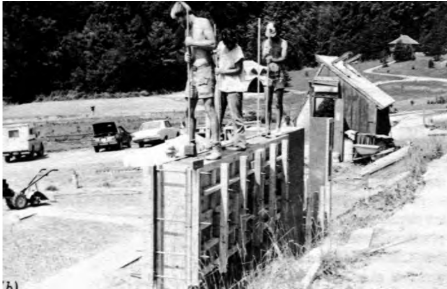
Figura 6. Encofrados para tapial
