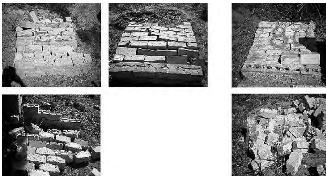
Figura 14. Fotografías de los muros colapsados
