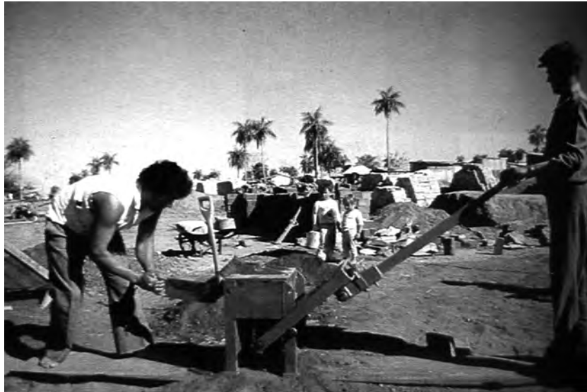
Figura 10. Fabricación de Bloques de Tierra Comprimida
