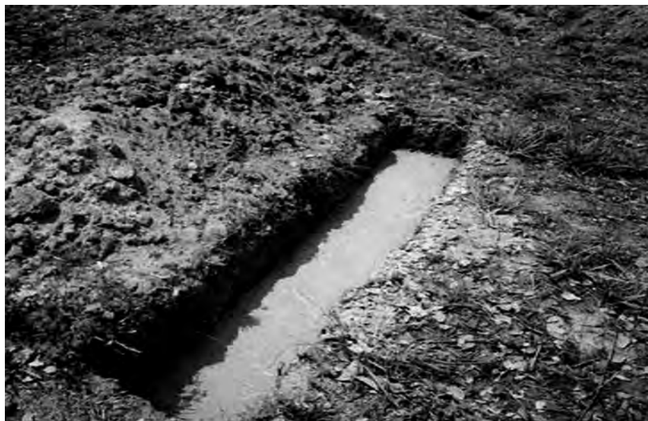
Figura 9. Vaciado o colado de concreto de cimentación
