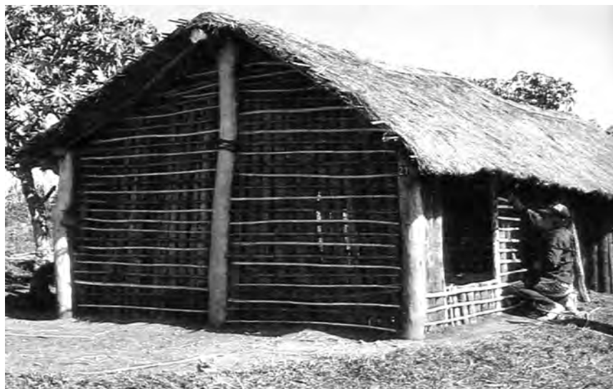
Figura 7. Construcción de bajareque
