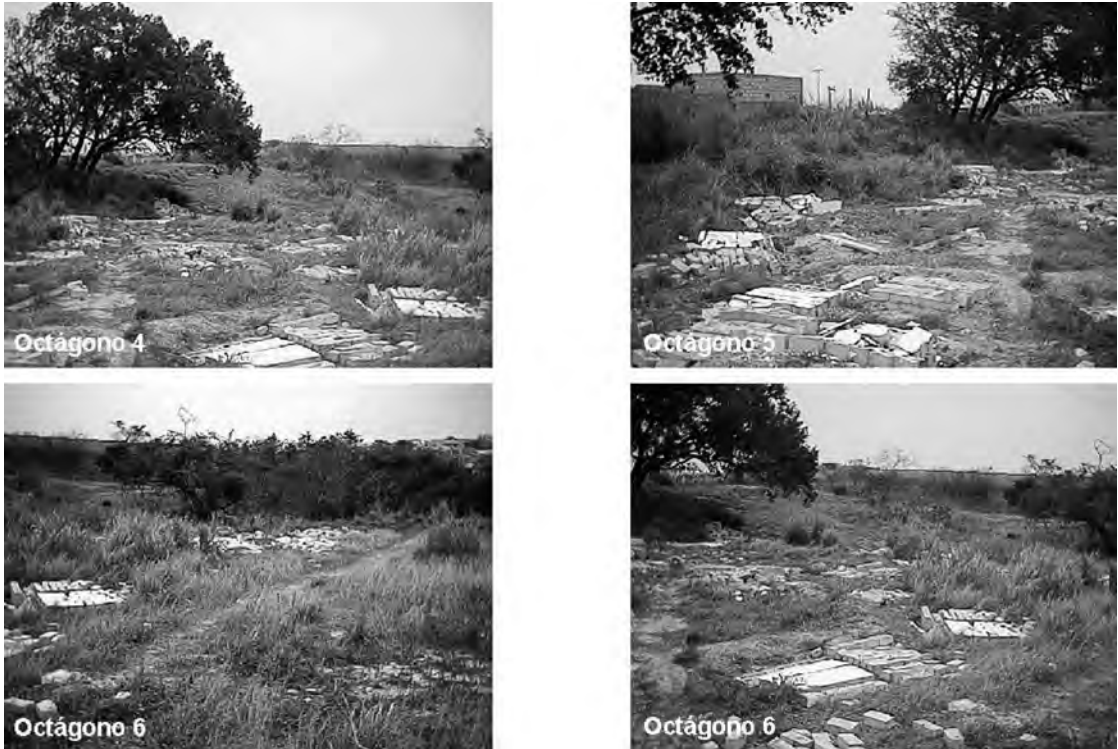
Figura 21. Fotografía de los octágonos 4, 5 y 6 colapsados
