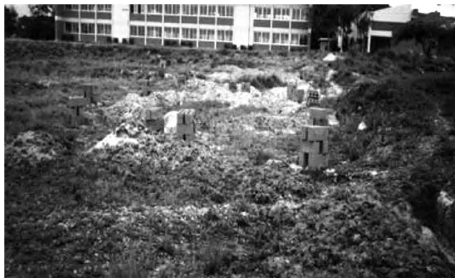
Figura 10. Construcción de zócalos
