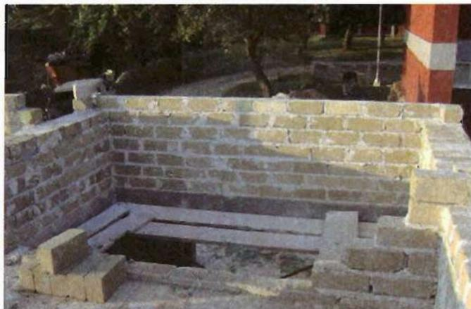
**Foto 41. Desplante de muros planta alta recámara oriente**
