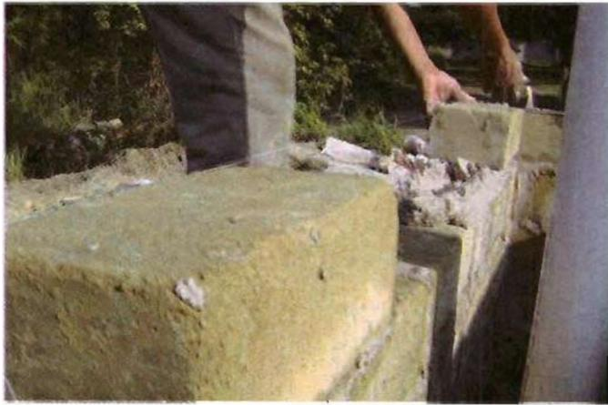
**Foto 19. Proceso de desplante de muros de BTC**
