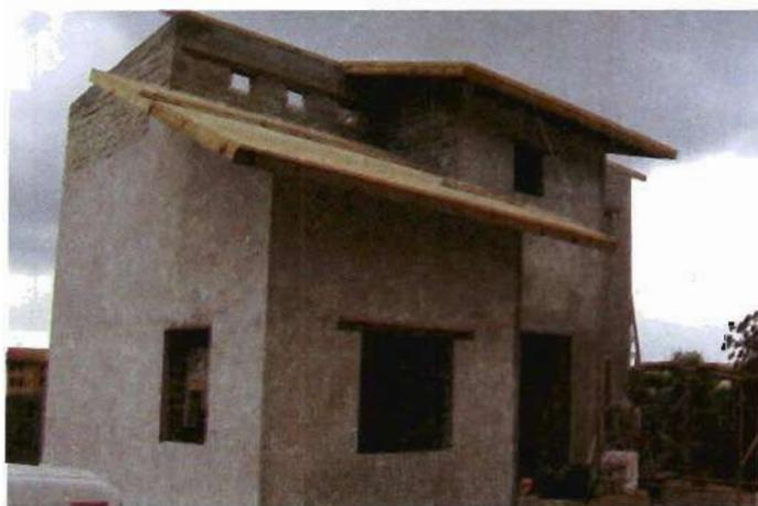
**Foto 52. Proceso constructivo de losa de azotea**
