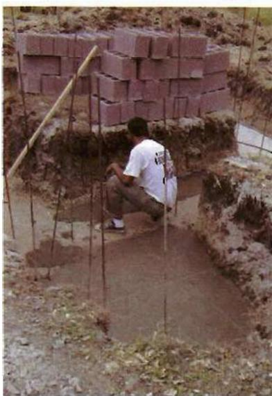
Después de hacer un análisis económico de las posibles cimentaciones superficiales a utilizar, se determinó que la más viable era la basada en zapatas corridas, posteriormente se realizó el cálculo estructural y se determinaron los espesores, diámetro del acero de refuerzo y resistencia del concreto. A continuación se presentan los datos obtenidos.
