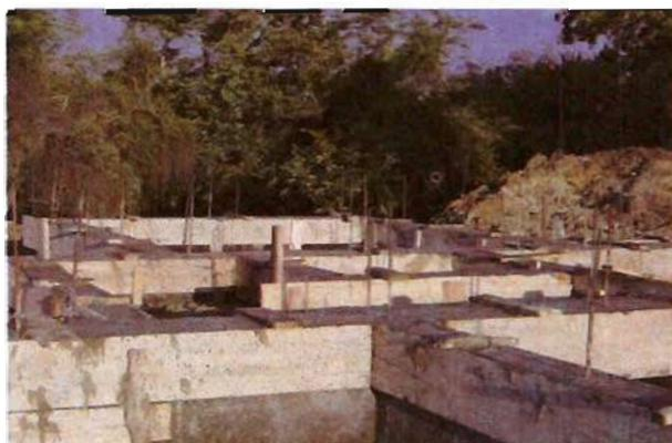
**Foto 13. Muros de BTC y sobrecimiento**
