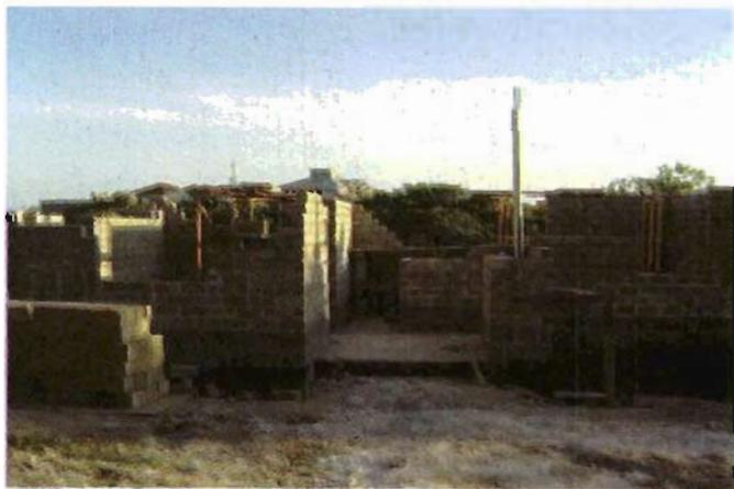
**Foto 20. Muros dobles de brc**
