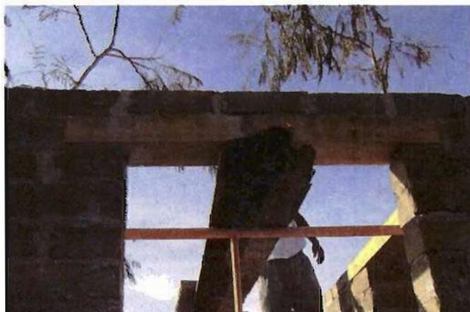
**Foto 23. Dintel de madera en cuarto de baterías**
