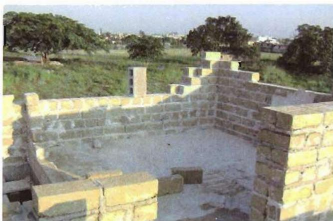
**Foto 42. Detalle de desplante de muros de baño y cubo instalaciones**
