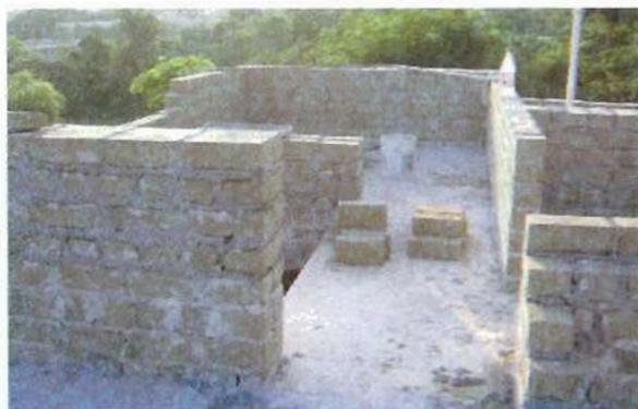
**Foto 40. Desplante de muros planta alta recámara poniente**
