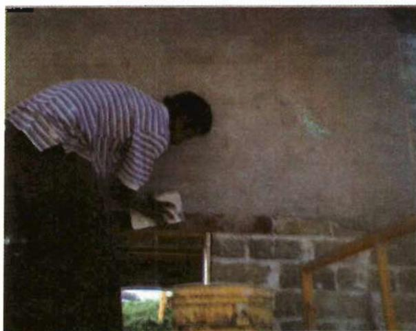
**Foto 60. Aplicación del revoque de cal-arena**
