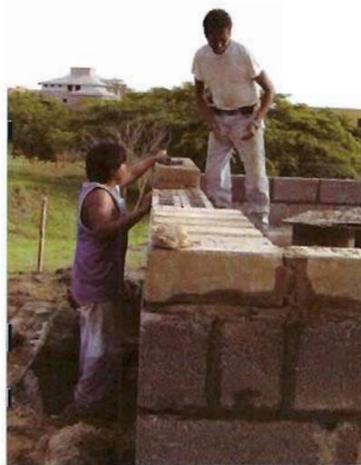
**Foto 15. Detalle de desplante de muro de BTC**
