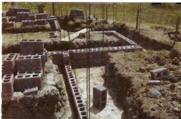
**Foto 9. Colocación de cadenas de cimentación**
