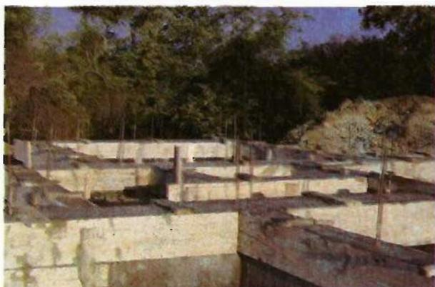
**Foto 29. Desplante de muros en la planta alta**
