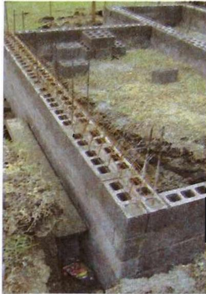
**Foto 10. Cadenas de cimentación e impermeabilización del rodapié**
