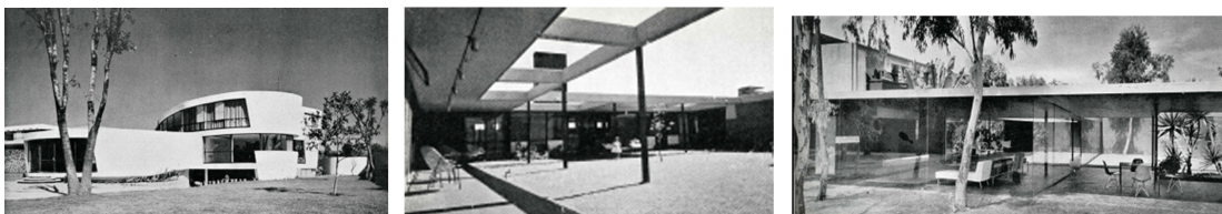
Fig. 3 De izquierda a derecha: Casa unifamiliar, Arq. Enrique Castañeda Tamborrel; Casa Silvia Pinal, Arq. Manuel Rosen; Vivienda unifamiliar, Arq. Héctor Velázquez y Ramón Torres.
