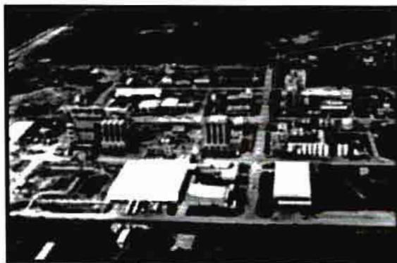
Industria petroquímica en Altamira.
